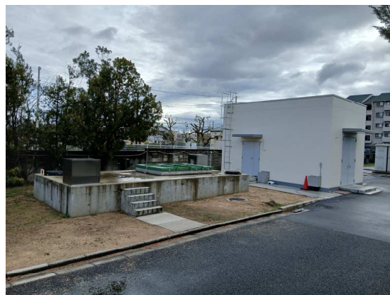
(阪神水道からの水道水受水施設(東部配水場内))
