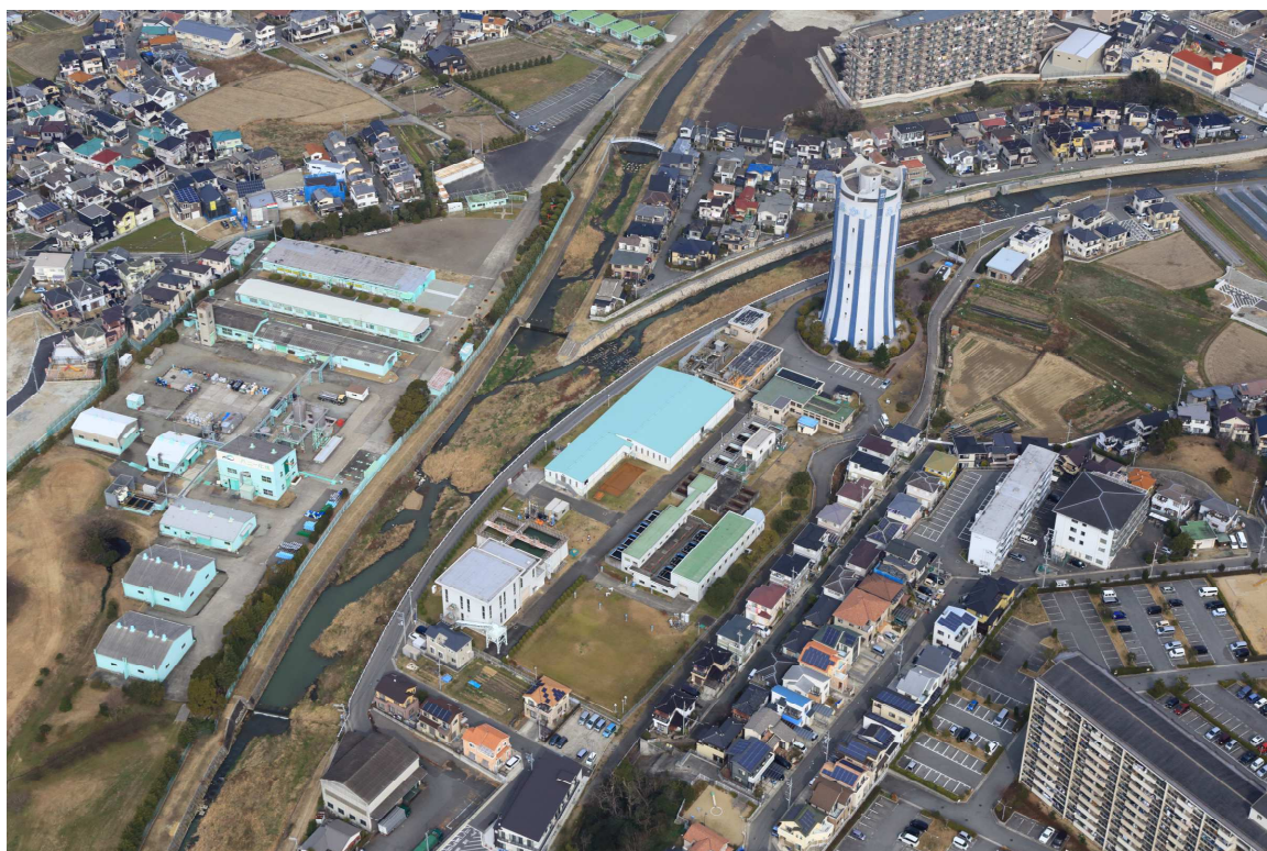
（魚住浄水場（現在、設備大規模更新中）の全景写真）
