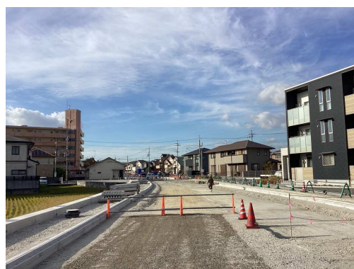
(大久保町大窪地内の水道管整備)
