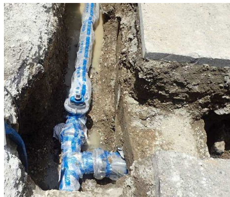
(老朽化した水道管の更新工事)
