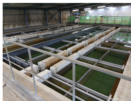
(更新前の設備更新対象箇所(抜粋))
