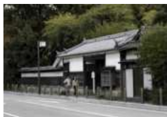
市指定建造物 織田家長屋門
