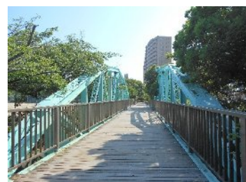
小久保跨線橋
