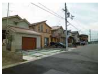
山電西二見駅周辺
