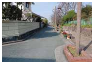
高丘地区の歩道
