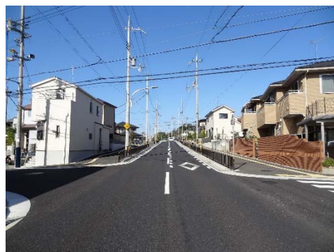
山手環状線(西工区)
