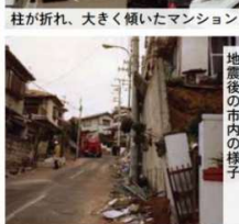
柱が折れ、大きく傾いたマンション
