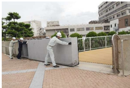
防潮ゲート点検(中崎展望広場)
