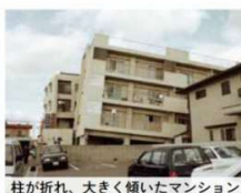
柱が折れ、大きく傾いたマンション
