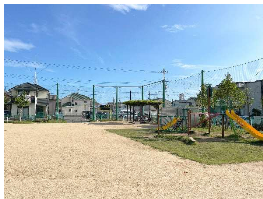
明南町中公園の遊具設置状況
