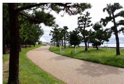
園路改修後(大蔵海岸公園)
