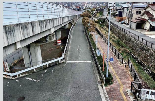
徳川道がつくられた朝霧川西岸
