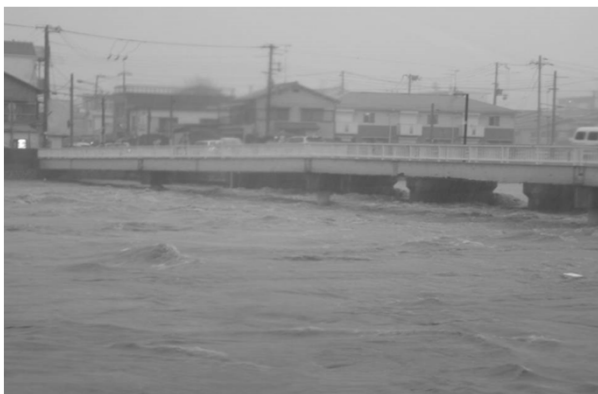
平成16年台風23号の豪雨により増水した明石川
