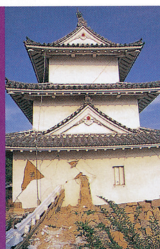
▲白壁にひびが入り、崩落した明石城・異櫓
