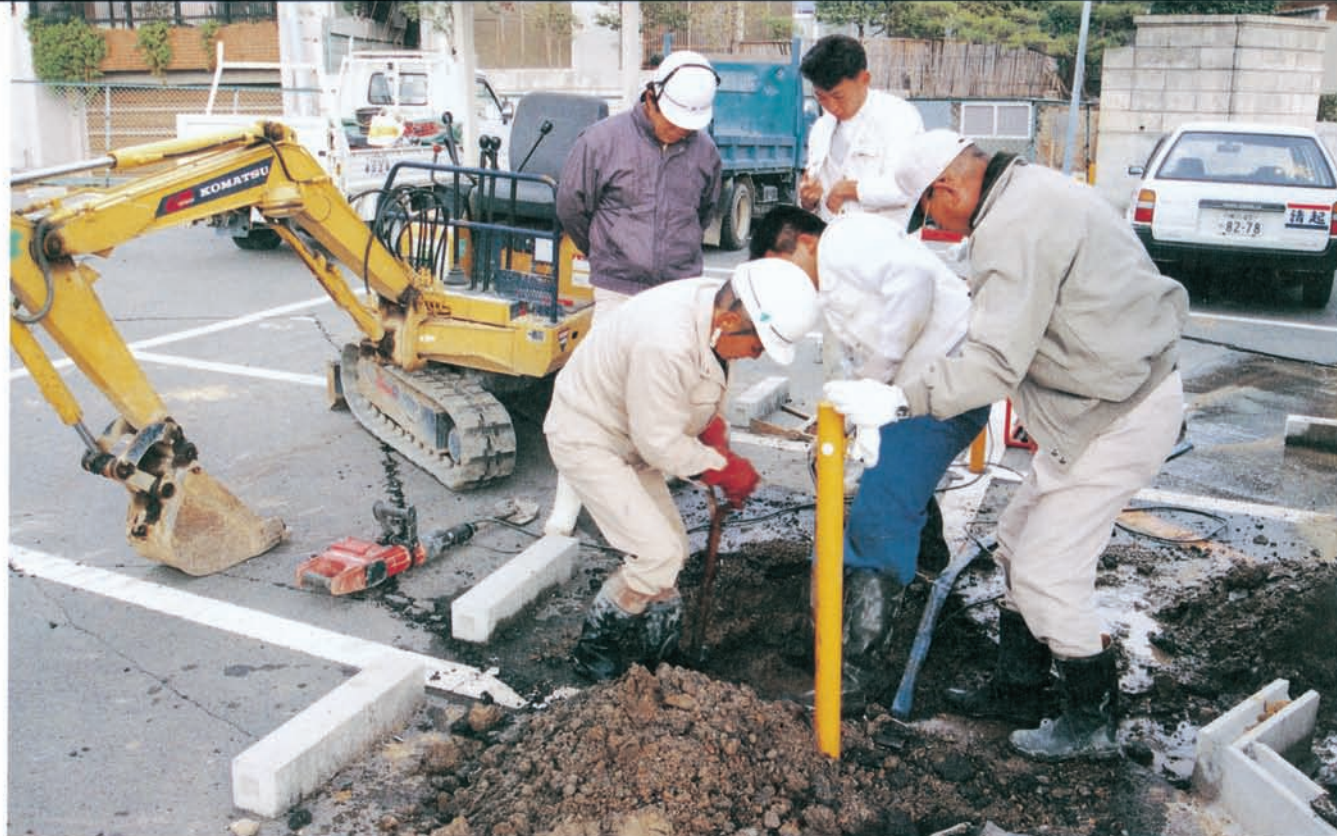
早期復旧をめざして24時間態勢で緊急修繕にあたった(東丸町)
