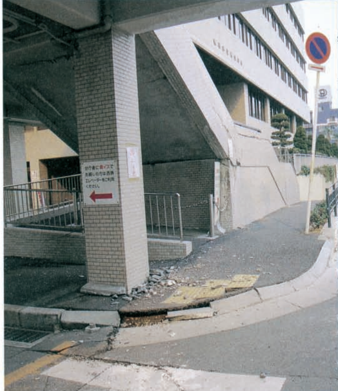
市内各所の道路で亀裂が入るなどの被害がでた(市役所前の市道)
