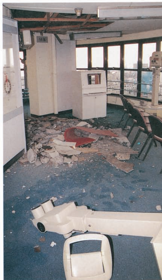
▲天井が落ち、望遠鏡が転倒した天文科学館展望室
