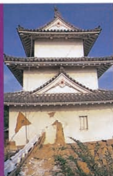
▲白壁にひびが入り、崩落した明石城・巽櫓
