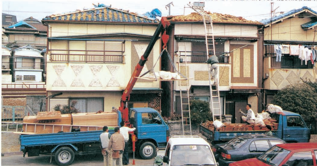
屋根を修理する家屋が市内でも多く見られた（大蔵町）
