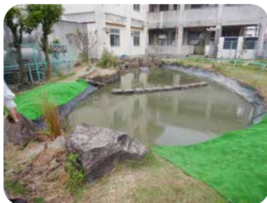
除去作業完了
