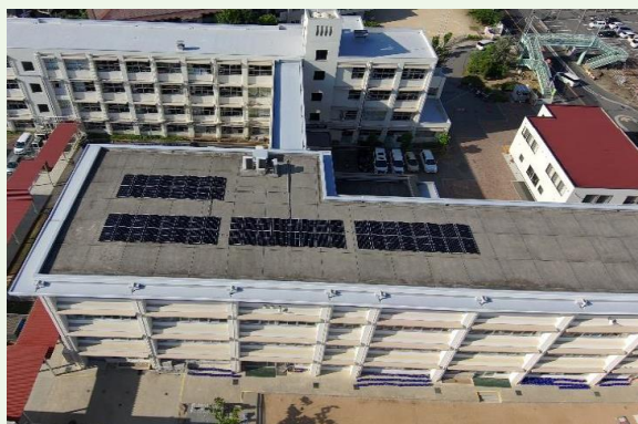
人丸小学校屋上の太陽光発電設備
