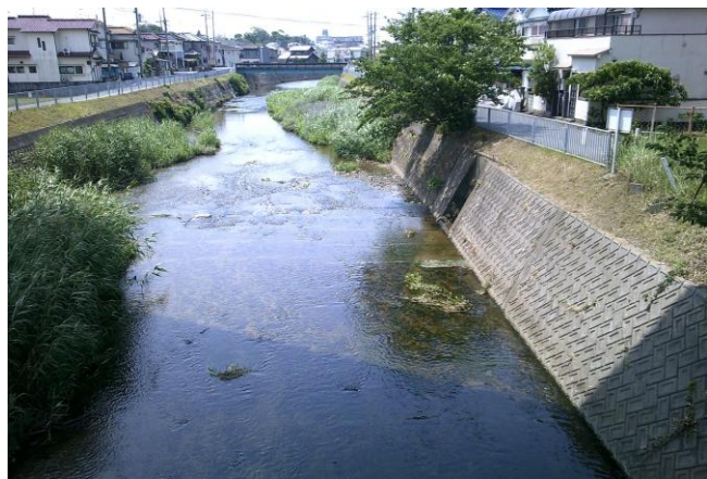
谷八木川測定地点(谷八木橋下流)
