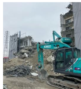
解体工事現場
