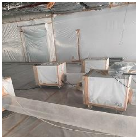
アスベスト除去作業現場
