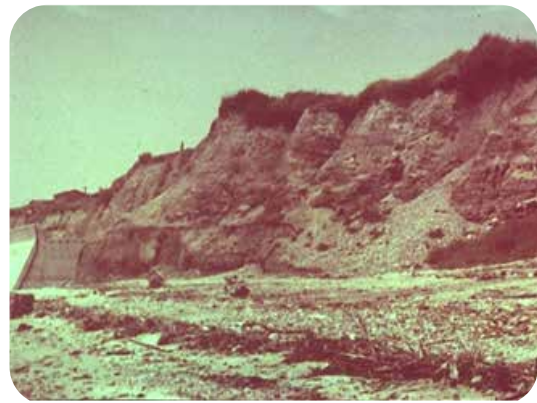
護岸の建設中（東松江地先 1967 年）
