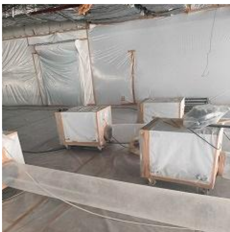
アスベスト除去作業現場
