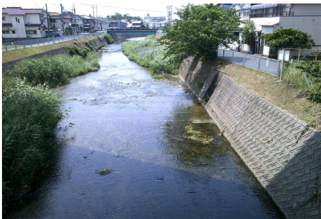
谷八木川測定地点(谷八木橋下流)
