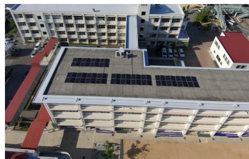
人丸小学校の太陽光発電設備
