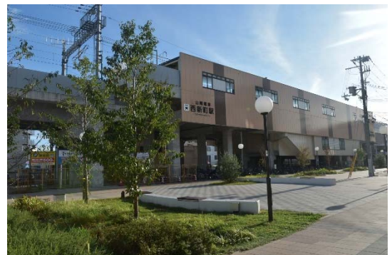
山陽電鉄連続立体交差事業(西新町駅)
