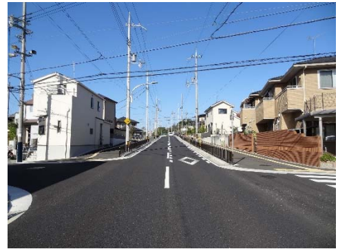
山手環状線(西工区)
