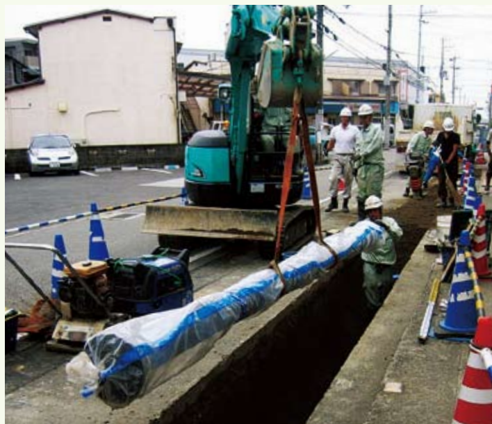
▶耐震管への取替え工事の様子
