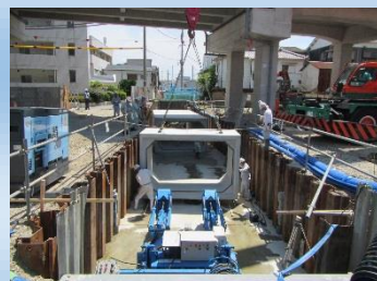
雨水BOXカルバート工事状況
