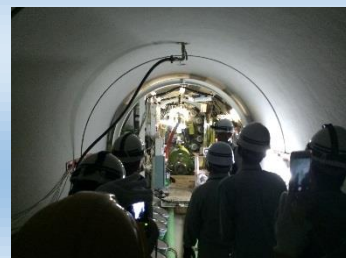
トンネル掘削機内の見学状況
