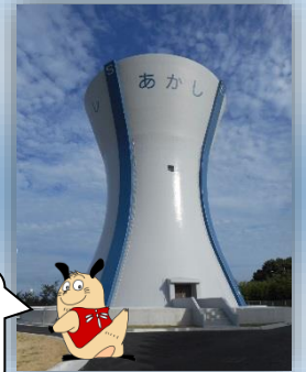
中部配水場 配水塔耐震補強
