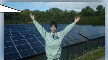
明石クリーンセンター 太陽光発電装置
