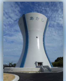
中部配水場 配水塔耐震補強
