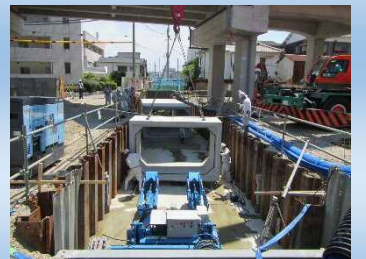
雨水BOXカルバート工事状況
