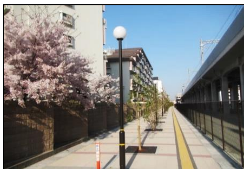
鉄道沿線に整備された歩道
