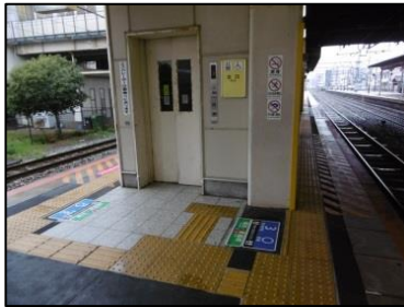
駅構内のエレベーター
