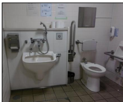
駅構内の多目的トイレ
