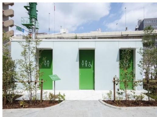
みんなが選べるオールジェンダートイレの設置例 (東京都渋谷区西原一丁目公園)
