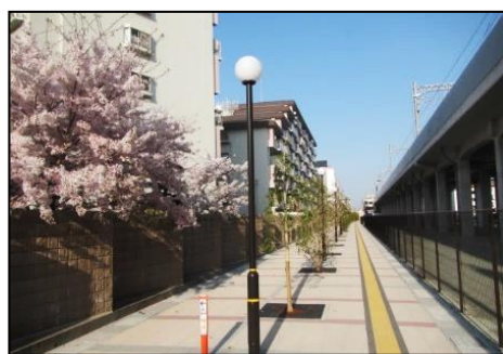
バリアフリー化された歩道
