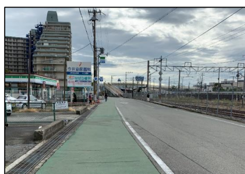
路側帯のカラー舗装(駅北側)
