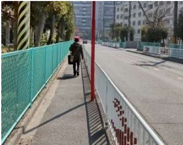
現在の歩道幅員(1.1m) (マックスバリュ前付近)
