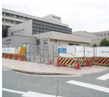
着々と工事が進む(鷹匠町)
