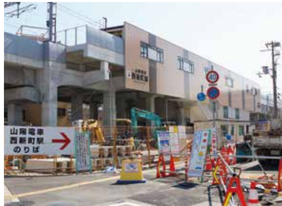
工事中の西新町駅前広場
