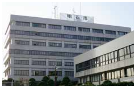
老朽化が進む市役所庁舎
