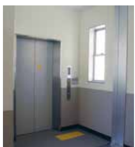
エレベーターは順次設置中
