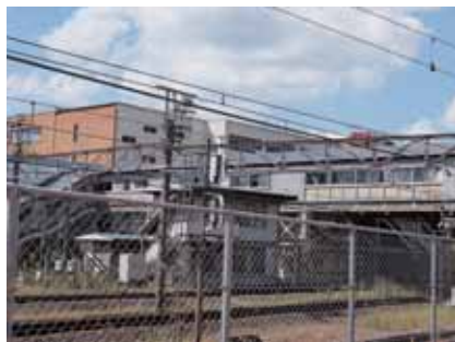
改修が望まれるJR西明石駅
