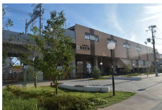
山陽電鉄連続立体交差事業 西新町駅前広場
