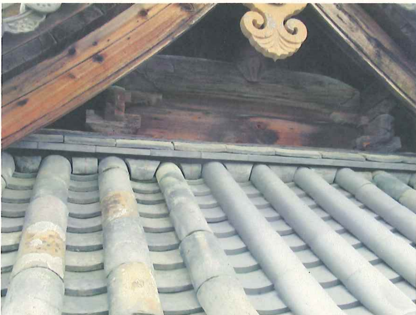
住吉神社楼門東面修理後
