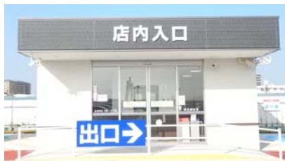
店内出入口（屋上駐車場）
