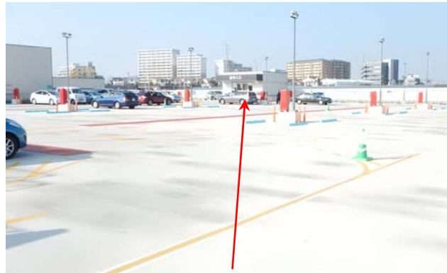
屋上駐車場（避難場所）
